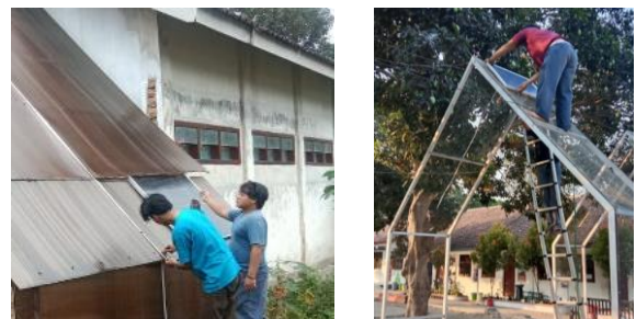
Gambar 5 pemasangan Panel Surya 200wp dan 50wp
