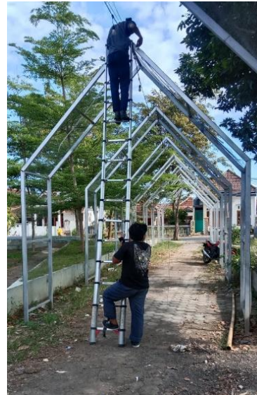
Gambar 4 Pemasangan lampu penerangan
